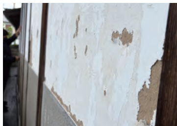
剥がれや、浮いてしまっている部分はスクレーパーなどで剥がします。
