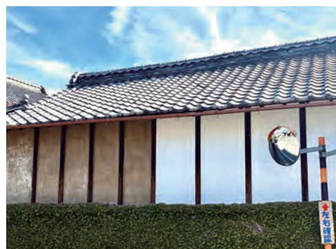
右側が仕上げ済み、左側は施工途中の壁。全体を3つに分けて少しずつ補修を進めた河合様。使用中でも材料の保管ができるので、このような施工が可能になります。
