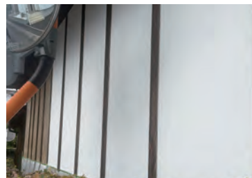
プライマーが乾いたら漆喰うま〜くヌレールを2回塗り。
