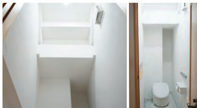
複雑な構造をしたトイレの天井部分。角の多さは施工の難しさであると同時に、陰影を際立たせる絶景ポイントとも言えます。
