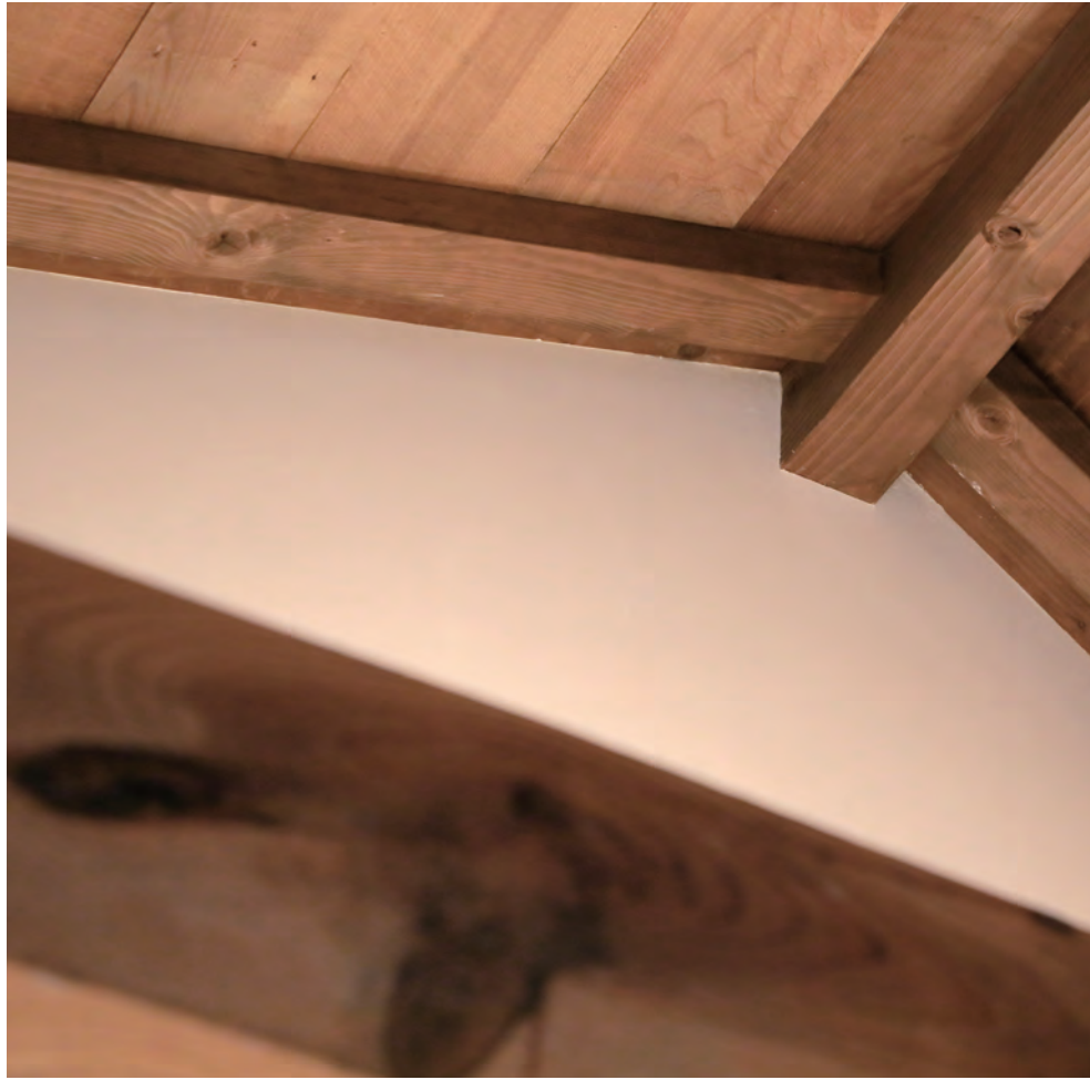
外壁に通じる重要な梁は「隠して残す」。塗られている漆喰は、建築に宿るストーリーを重視する光嶋氏のリクエストに応え、藤枝市産のお茶のエキスを練り上げた特製「お茶漆喰」。同じ漆喰はコントロールルームと宿泊施設の壁にも使用されている。
