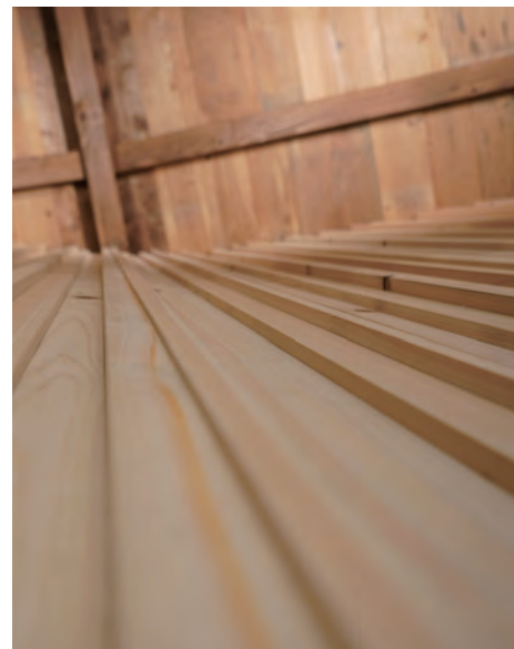
漆喰壁の正面は、数種類の板材をランダムに貼り合わせた乱張り。窓の少ないスタジオ内が単調にならないよう、多くの陰影をつくる光嶋氏のこだわりが生み出した不揃いの美。結果的にこの乱張りによって、さまざまな周波数の音を跳ね返し、やわらかい音の表情になるという機能性まで兼ね備えた。
