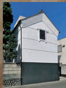
綺麗に改修された蔵の外観 からは、内にスタジオがある とは思えない。
